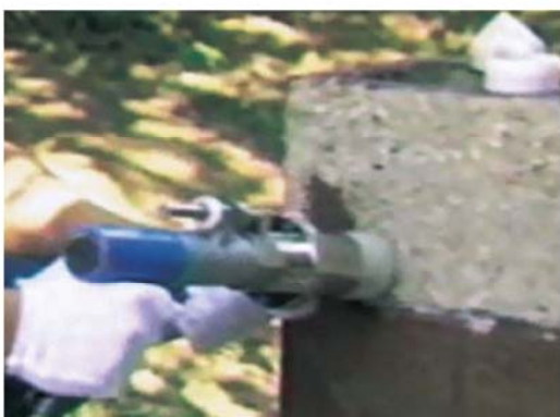
コンクリート面の研削
